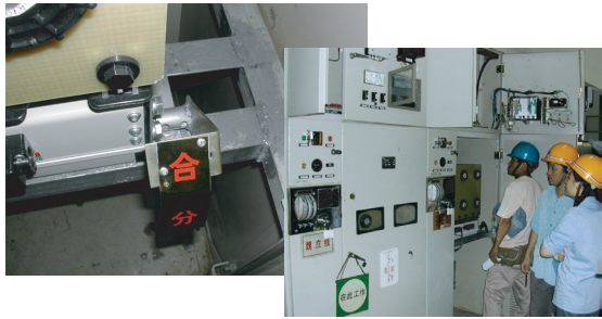
湖北襄樊220kV变电站XGNII型开关柜改造 使用8台ISM-31.5kA/1250A 2005年项目施工周期仅2周
