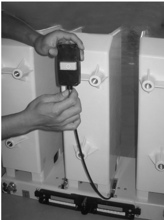
Figure 76 Régler l'indicateur pour les deux états, ouvert et fermé, du module de commutation.
